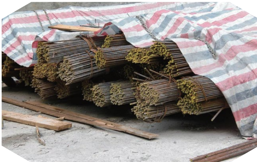
鋼筋塗上顏色漆油以作識別
